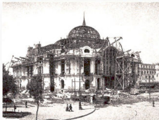
Fig. 3.53 Los trabajos de construcción del "Teatro Nacional", conocido en la actualidad como Palacio de Bellas Artes, comenzaron en 1904 y finalizaron en 1934.
